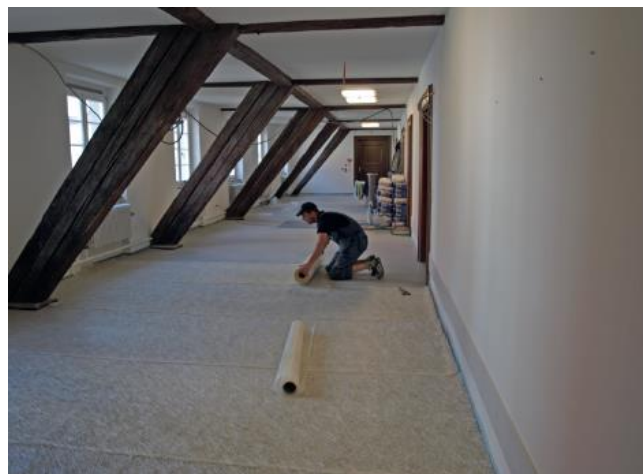
Plošné uloženie rohože UZIN RR 201 na sanovaný podklad
